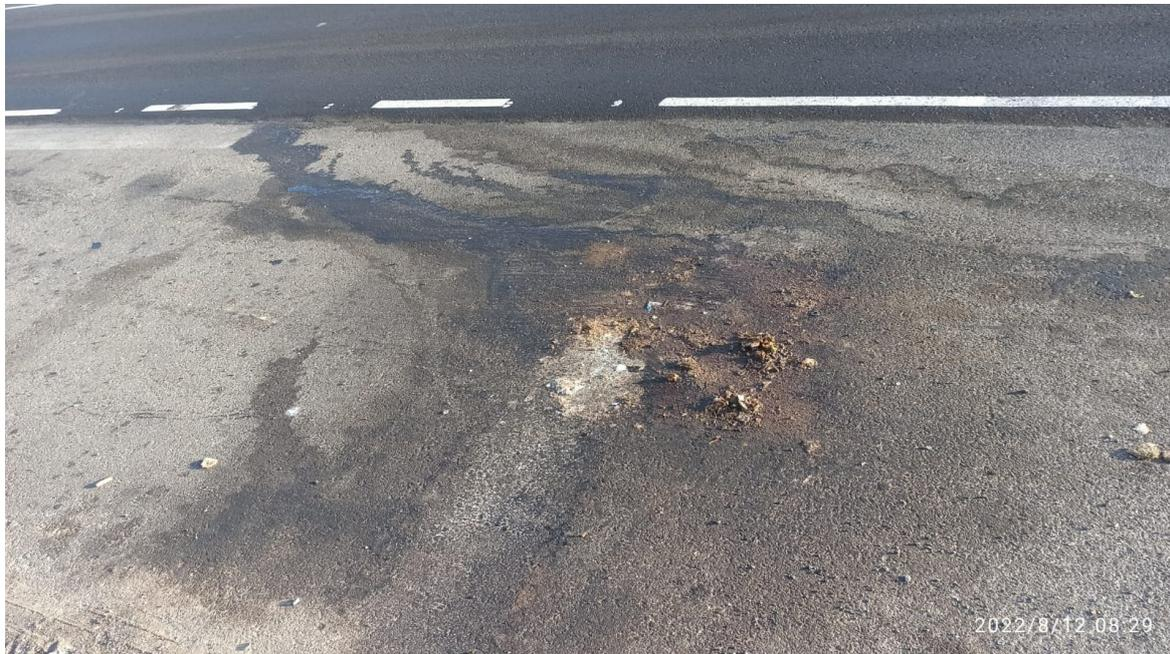
**FALTA:** Derrame de líquidos hidráulico de los camiones del servicio.13/12/2022.
